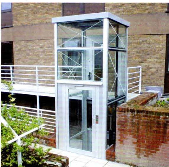
Due esempi di ascensori oleodinamici in un interno e un esterno. Si evidenziano le ridotte dimensioni del vano corsa e la versatilità delle installazioni, che si adattano ai contesti più diversi. Nell'esempio di sinistra si notano i due livelli ravvicinati e le aperture su due lati opposti ( DomusLift di IGV).
