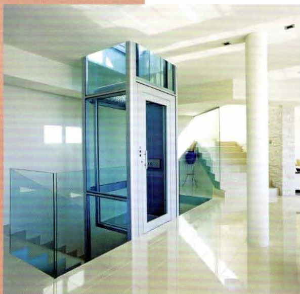
Due esempi di ascensori oleodinamici in un interno e un esterno. Si evidenziano le ridotte dimensioni del vano corsa e la versatilità delle installazioni, che si adattano ai contesti più diversi. Nell'esempio di sinistra si notano i due livelli ravvicinati e le aperture su due lati opposti ( DomusLift di IGV).
